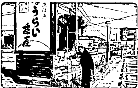
県道熊本空港線交差点改良 (長嶺東6丁目・ほうらい茶屋付近) 用地交渉中
