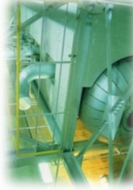
基幹的設備改良(廃熱ボイラ等)
