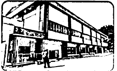
二岡中体育館新築完成
