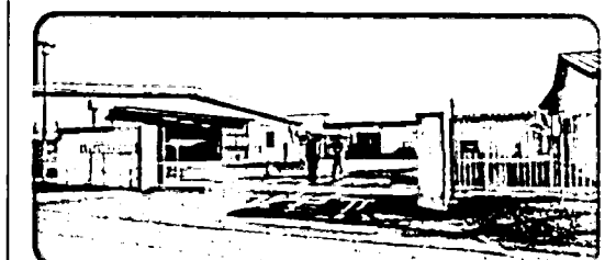
完成した堆肥センター
