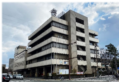
被災した消防局庁舎
