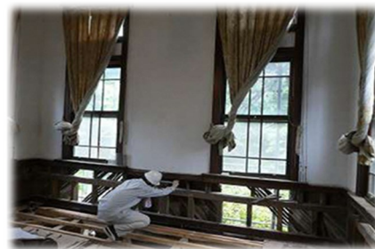
夏目漱石内坪井旧居の復旧
