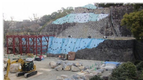
飯田丸五階櫓石垣の復旧工事
