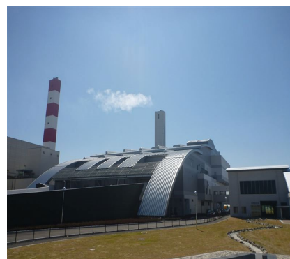
西部環境工場(発電した電力の活用)
