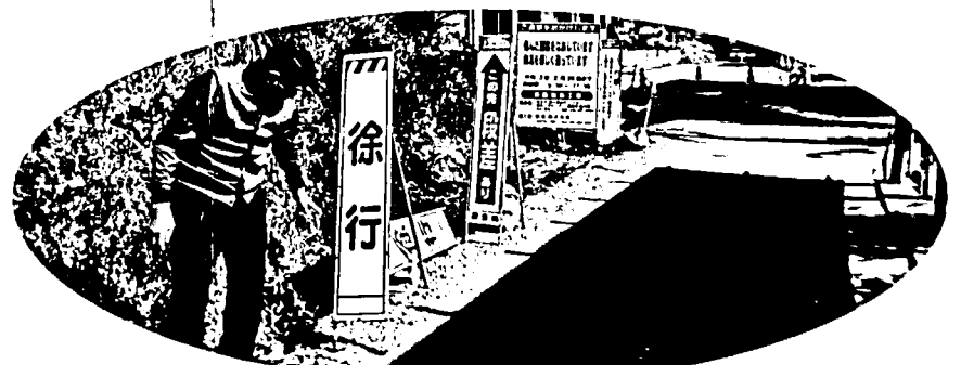
八反田2丁目市道道路改良工事
