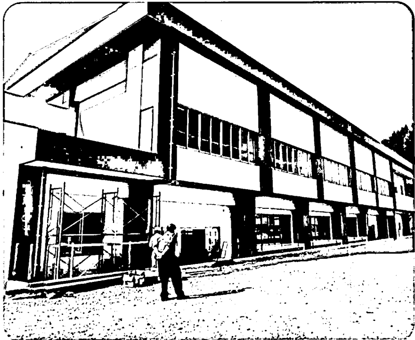
二岡中体育館 間もなく完成
