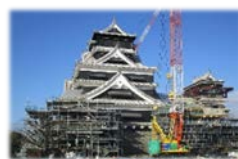
熊本城の天守閣復旧工事
