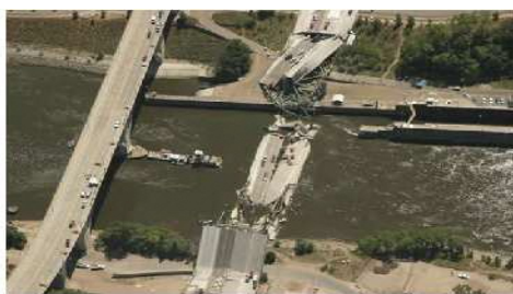
写真1 橋梁崩落事故の状況
