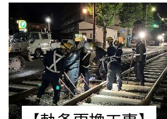
【軌条更換工事】
