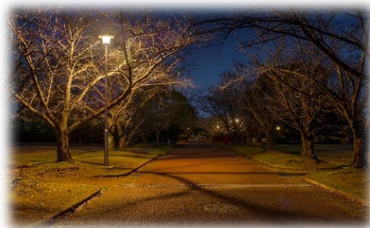
公園照明灯のLED化
