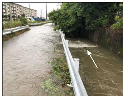
▲藻器堀川の溢水状況 (未改修区間-八反田3丁目)
