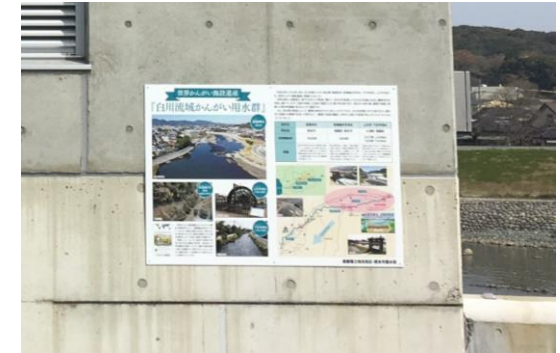
渡鹿堰の操作室壁面に設置した説明板
