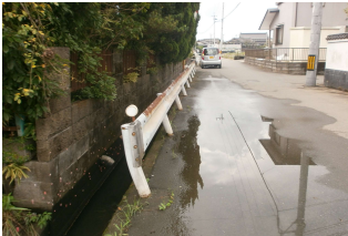
塀と道路との間に水路がある
