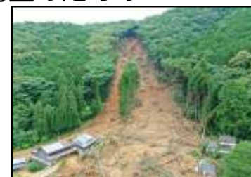
山腹崩壊の状況
