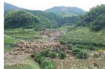
土砂等が堆積した果樹園地
