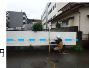
井芹川第8・10排水区浸水痕
