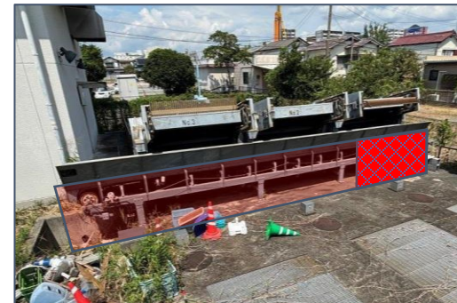
除塵機周りへの夾雑物混入防止対策
