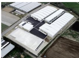
熊本市東部堆肥センター
