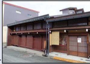
修理された建築物 ▶
