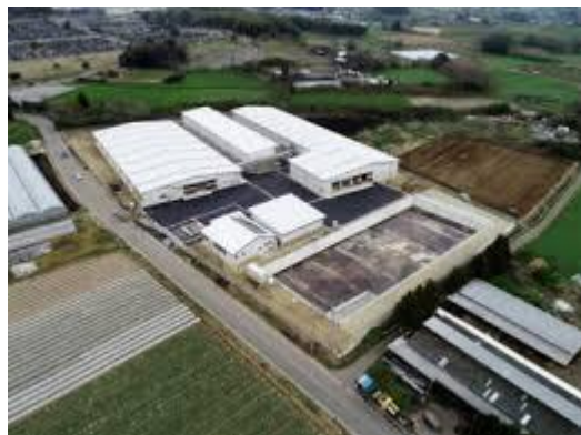
▼熊本市東部堆肥センター
