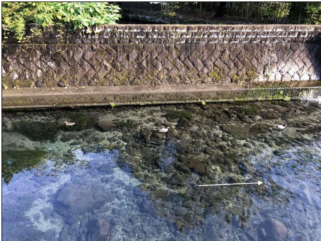
藻器堀川下流端付近の状況
