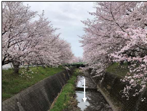
保田窪放水路・白川合流点付近
