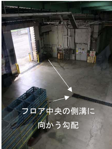
図 4-3 工場棟写真①
