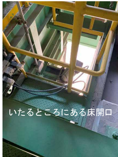
図 4-4 工場棟写真②
