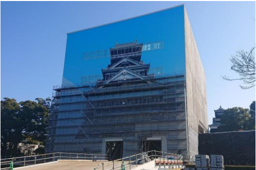
宇土櫓解体保存工事外観
