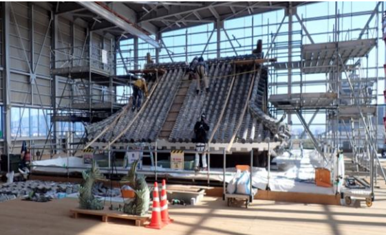
宇土櫓解体保存工事内部の様子
