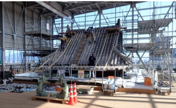
宇土櫓解体保存工事内部の様子
