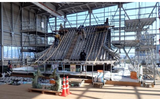
宇土櫓解体保存工事内部の様子
