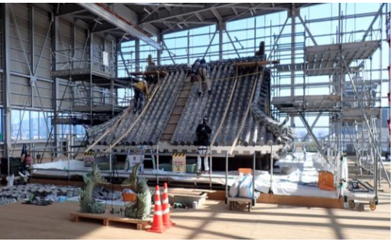
宇土櫓解体保存工事内部の様子
