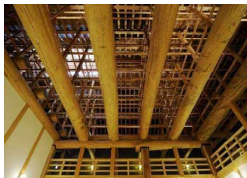
復元工事に使われた木材(本丸御殿)
