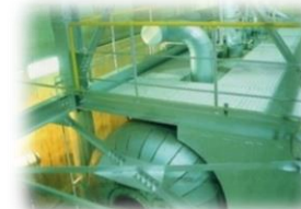
基幹的設備改良(廃熱ボイラ等)
