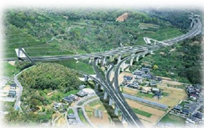
▲熊本西環状道路(池上・砂原工区)
