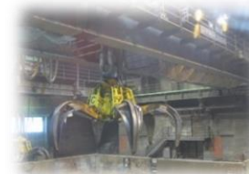
クレーン設備改修
