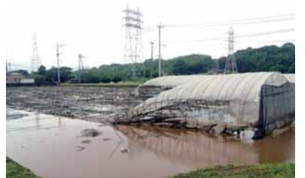
東区供合地区 農地・ハウス被害の状況
