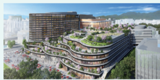
平成31年夏期施設完成予定です
