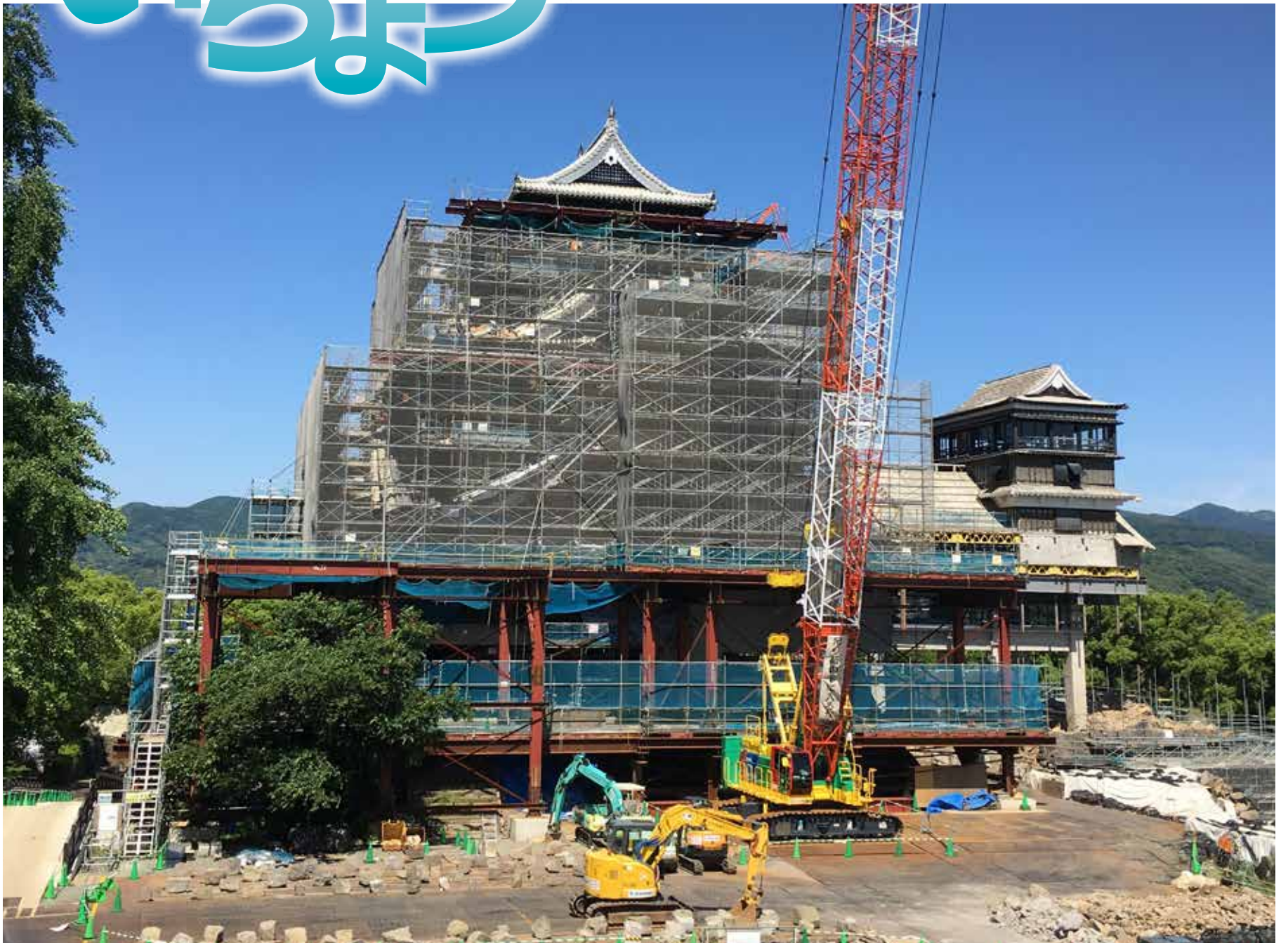
復旧工事中の熊本城天守
